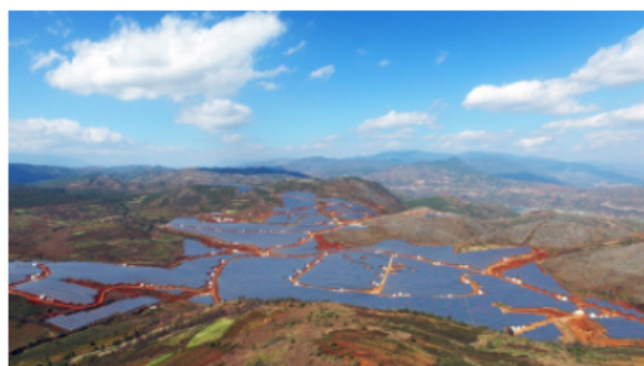
中华电力云南大理西村100MW农光互补示范... 应用机型: SG 1000TS (下线)
