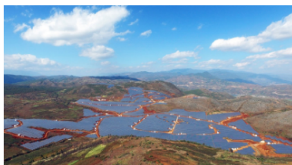
中华电力云南大理西村100MW农光互补示范... 应用机型: SG 1000TS (下线)
