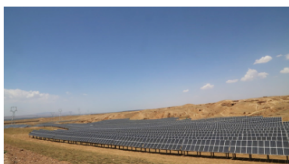
宁夏同心县隆基二期40MW光伏电站 应用机型: SG500MX SG 1000TS-M (下线)
