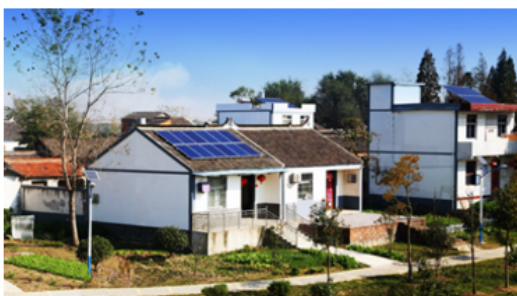
安徽肥东长临河镇罗洪村户用屋顶光伏发电...
